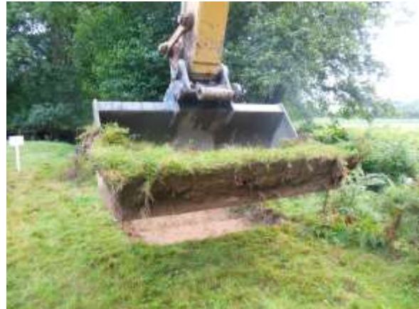
Les plaques de terre seront enlevées avec un godet sans dent (source GERE A)
