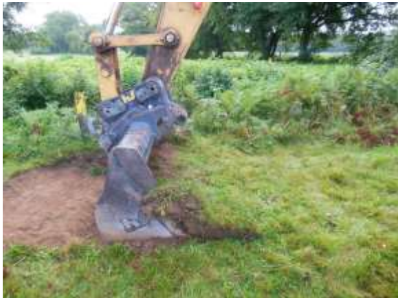
Les plaques de terre seront enlevées avec un godet sans dent (source GERE A)
