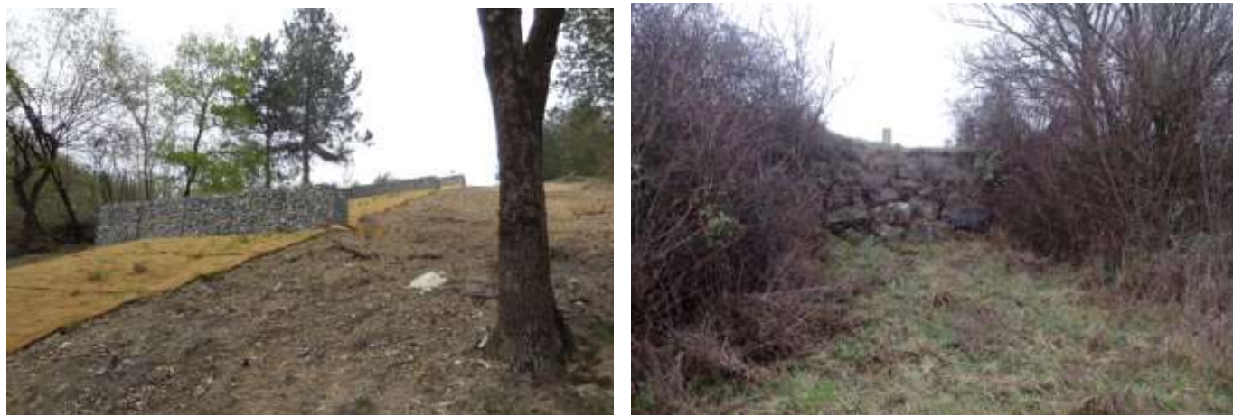
Exemple de mesure visant à la stabilisation des terres et à la limitation du ruissellement sur une piste de travail, à gauche juste après travaux, à droite après cicatrisation des milieux
