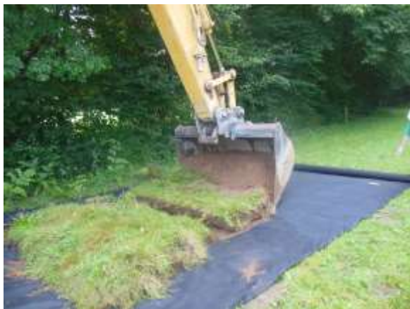
Les plaques de terre seront enlevées avec un godet sans dent (source GERE A)
