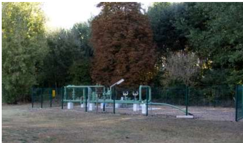
Poste de sectionnement type
